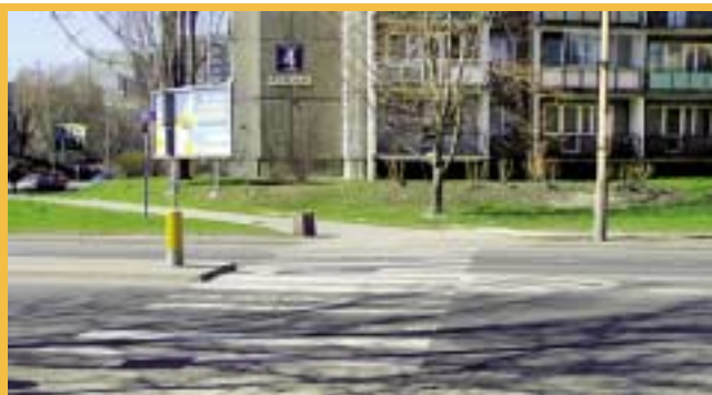
14. ábra: Az átkelőhely jobb oldalán hiányzik a sziget védelme
