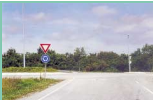
4. ábra: A csomópont a magassági lekerekítés miatt rosszul látható
