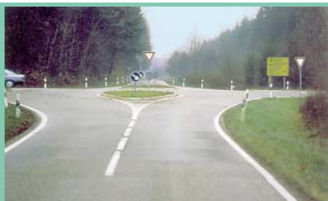
6. ábra: A szélesebb szigetek forgalomelterelő hatása kedvezőbb
