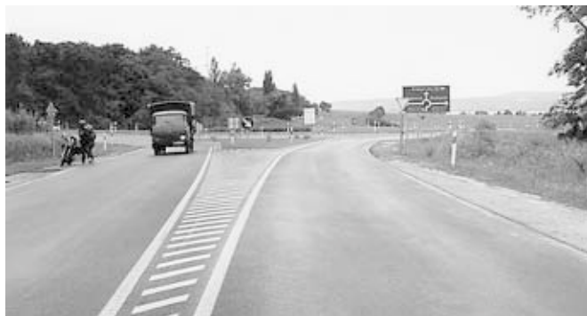
18. ábra: A csomópont a 68. sz. út felől érkezve
