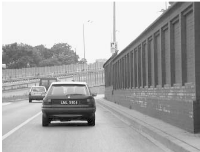
19. ábra: A zajvédő fal akadályozza a látást
