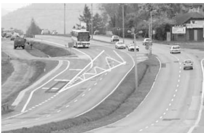
18. ábra: A becsatlakozó sávon közlekedő jármű látómezején kívül esik a közeledő busz
