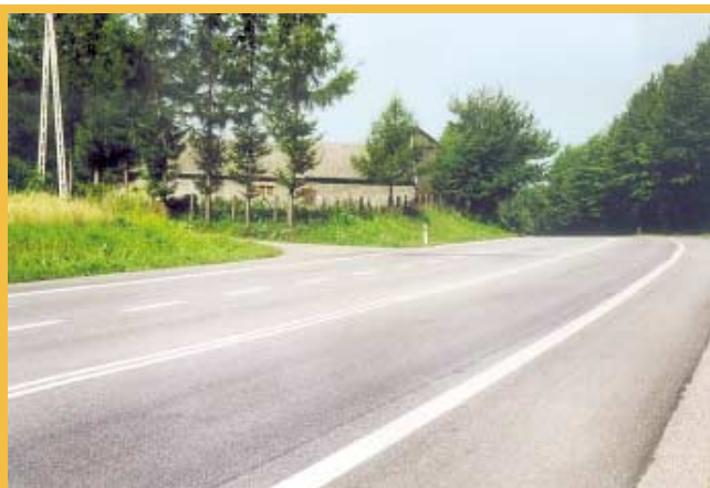
3. ábra: Ív belső oldalán kialakított csatlakozással
