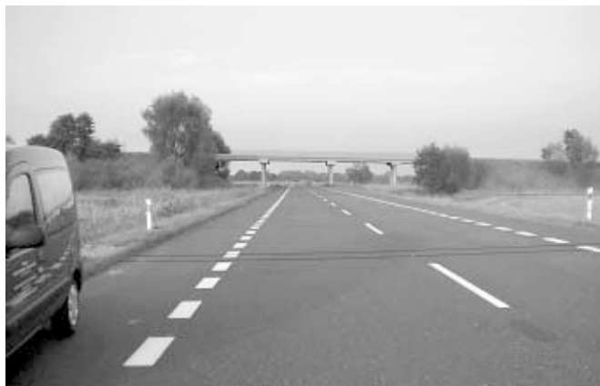
2. ábra: Z1 típusú útkeresztmetszet burkolt padkával külső szakaszon
