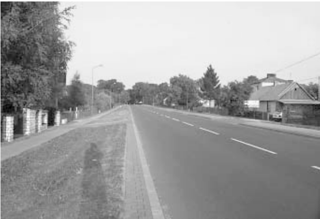
8. ábra: Z2 típusú útkeresztmetszet átkelési szakaszon
