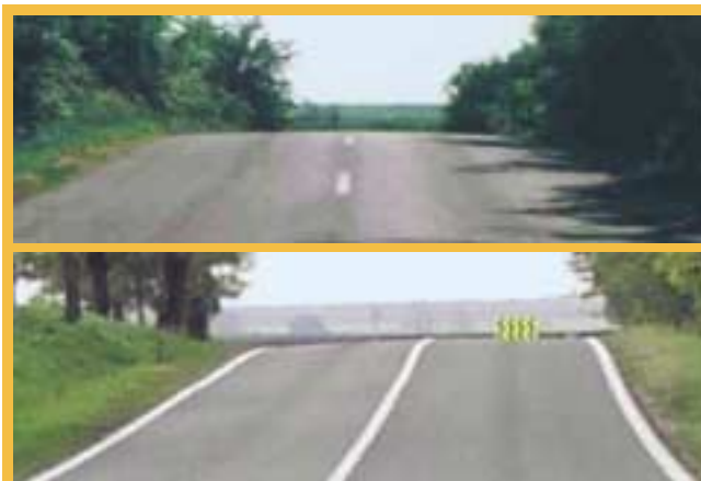
11. ábra: A bukkánó és az ív az átalakítás előtt és után
