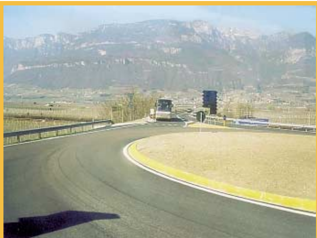
10. ábra: A behajtó ág előnytelen kialakítása
