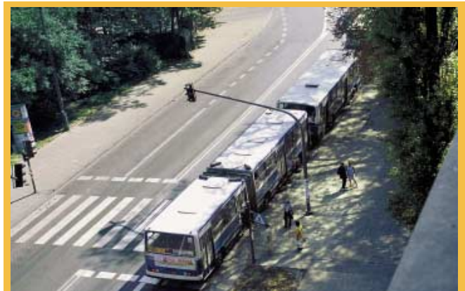
20. ábra: A megállóhely nem elég több busz egyidejű megállására
