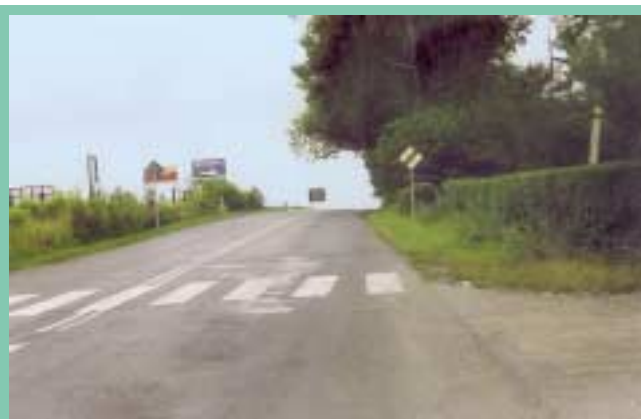
17. ábra: Az ellenirányból rosszul látható átkelőhely, függőleges lekerekítésben, vízszintes ívben
