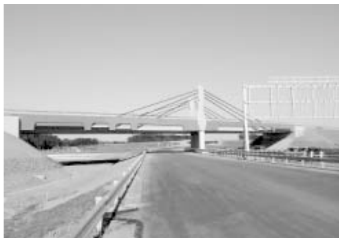
11. ábra: Az elkészült híd
