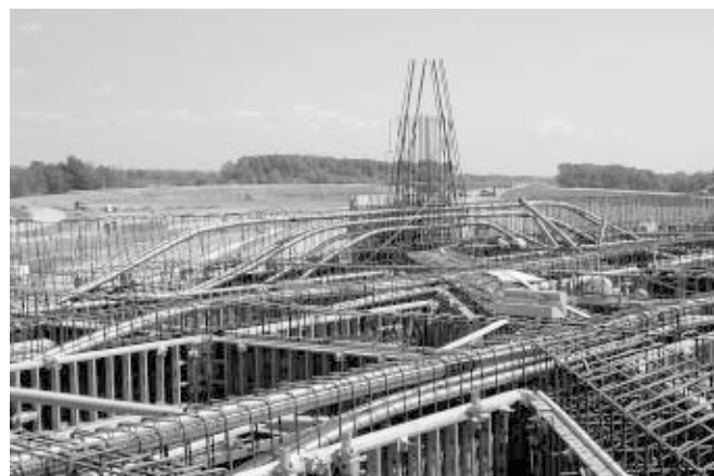
8. ábra: Injektált kábelek vonalvezetése a támasz felett
