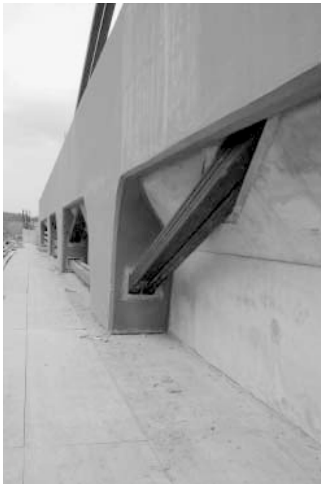
10. ábra: Iránytörő a befűzött és megfeszített csúszókábelekkel
