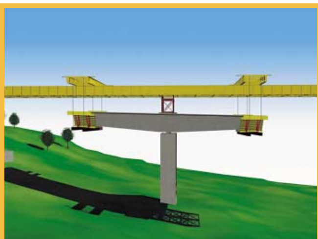
10. ábra: A felszerkezet építésének látványterve
