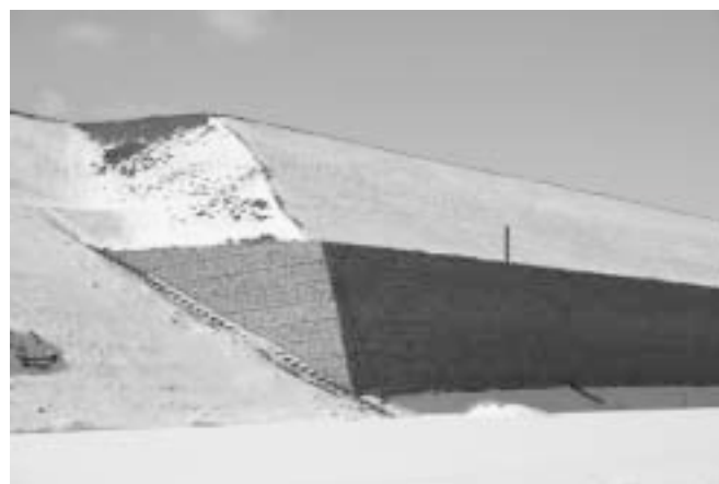
8. ábra: Megépült Terratrel támfal
