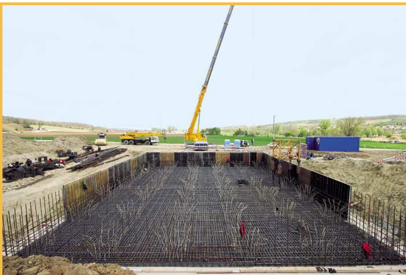
5. ábra: Talpgerenda vasszerelése
