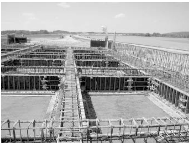
7. ábra: Az alsó vasbeton lemez és a bordák betonozása
