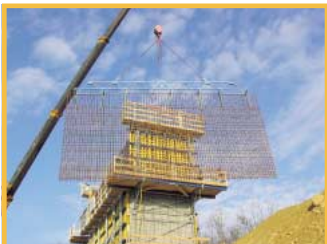
7. ábra: Előszerezelt vasalás beemelése
