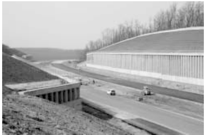
4. ábra: Megépült cölöptámfal
