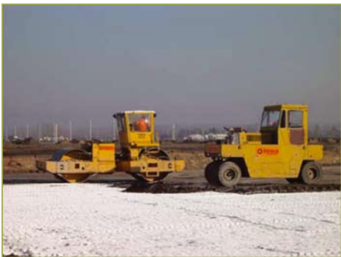
6. ábra: Vibrohenger munka közben
