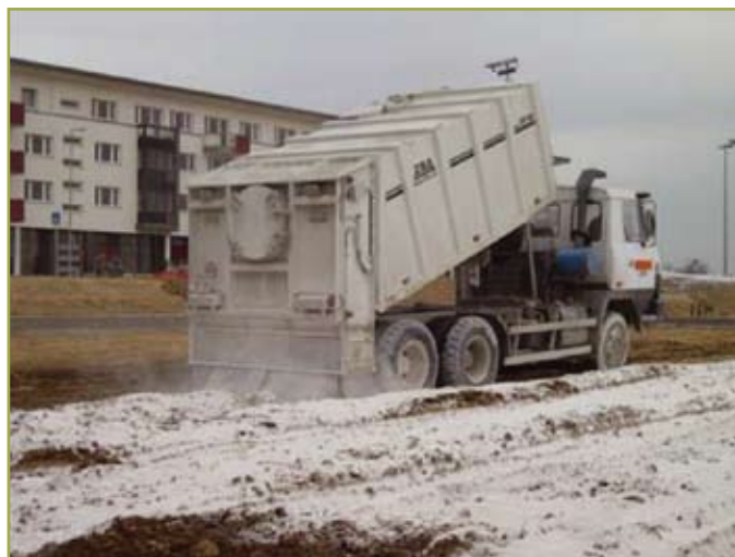
3. ábra: A mész egyenletes kijuttatása kötőanyagszóró gépből
